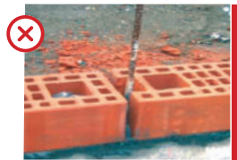
· Corte inadecuado.
