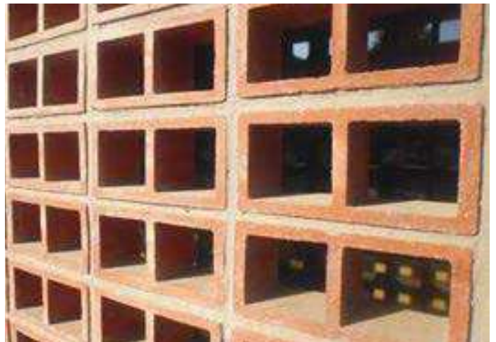
Con cantería, pega con mortero predosificado
