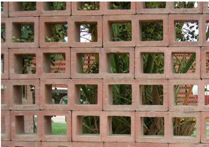
Sin cantería, pega con adhesivo cerámico
