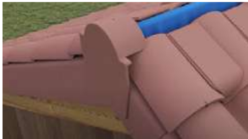
Detalle de pieza especial Tapón de cumbrera.
