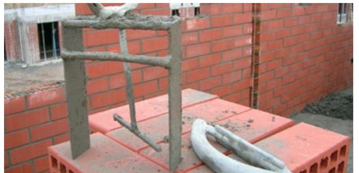
No debe moverse ningún ladrillo después de fraguado el mortero, ya que esto rompe la adherencia.
