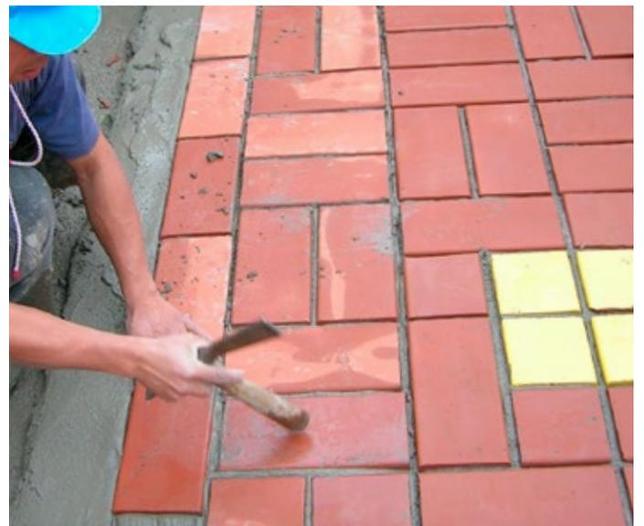
El instalador deberá usar como herramienta para asentar correctamente el Baldosín, un martillo con mango de madera extremo, o bien un combo de goma, con el cual deberá dar pequeños golpes para ir dando la posición dentro de la hilera y ajustando su nivel, asegurando que no queden burbujas de aire bajo el producto, asentándolo 1 [cm] en el mortero fresco, de manera que posteriormente se materialice la cantería. Se recomienda limpiar a medida que se va instalando.
