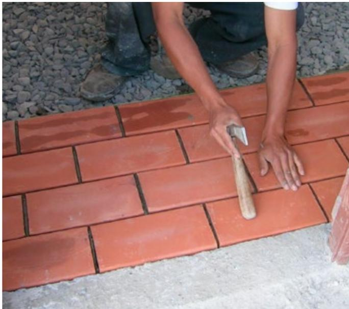
extremo, o bien un combo de goma, con el cual deberá dar pequeños golpes para ir dando la posición dentro de la hilera y ajustando su nivel, asegurando que no queden burbujas de aire bajo el producto, asentándolo 1 [cm] en el mortero fresco, de manera que posteriormente se materialice la cantería.
