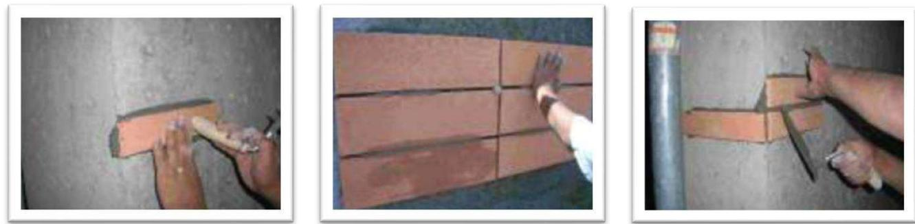
Como se produce un exceso de mortero al realizar la colocación (rebalse), el instalador debe eliminar suavemente todo este exceso en las caras libres, para así tener una superficie despejada para colocar el siguiente enchape, respetando tanto el espesor de capa como la cantería indicada para el proyecto.
