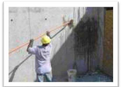
En caso que después del lavado persistan zonas con presencia de desmoldante, se recomienda realizar un lavado con agentes detergentes y luego lavar con abundante agua a presión, con el fin de eliminar los restos que aun queden.
