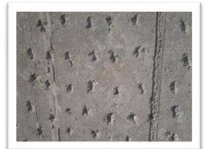
Luego de realizado el puntereo, es necesario eliminar todo el material suelto, polvo y restos semiadheridos al hormigón tales como lechada de cemento, yeso, madera, etc. Esta tarea se realiza con la pasada de una escobilla con cerdas de acero sobre la superficie del sustrato a enchapar. Luego se debe lavar la superficie con agua a presión, para eliminar el desmoldante de los encofrados que quede en la superficie.
