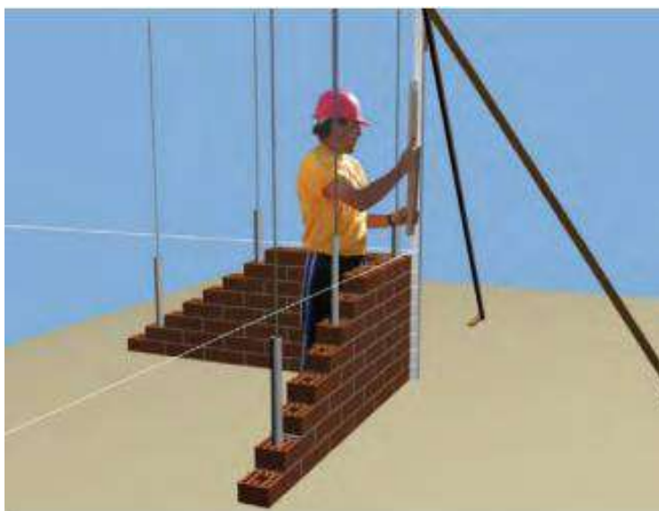
Detalle de Regla con escantillón y lienza
