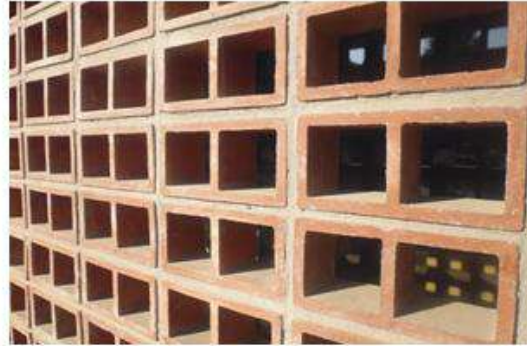
Formato de instalación sin trabazón entre hiladas
