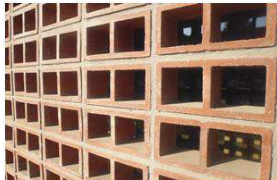
Con cantería, pega con Mortero predosificado
