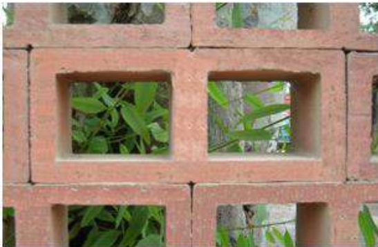
Sin cantería, pega con Adhesivo cerámico
